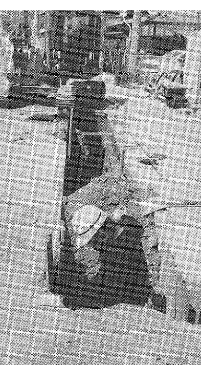
快適な暮らしに欠かせない下水道の工事
