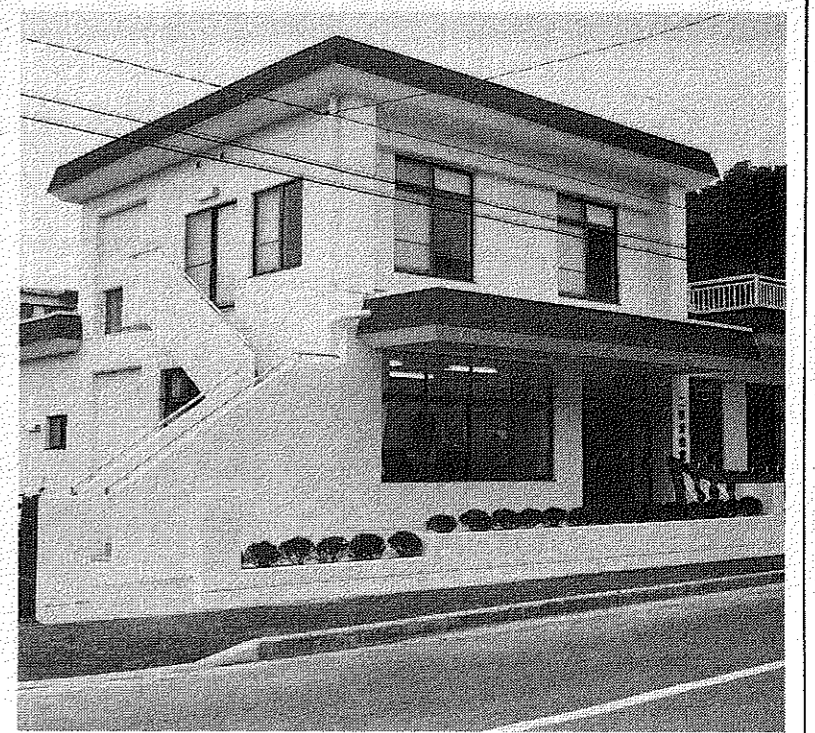
鉄筋コンクリート造り2階建てのスマートな建物に生まれ変わった二区公会堂
