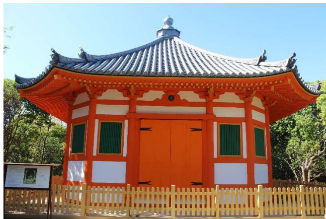
保存修理工事後の八角堂
