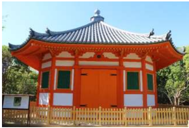
保存修理工事後の八角堂
