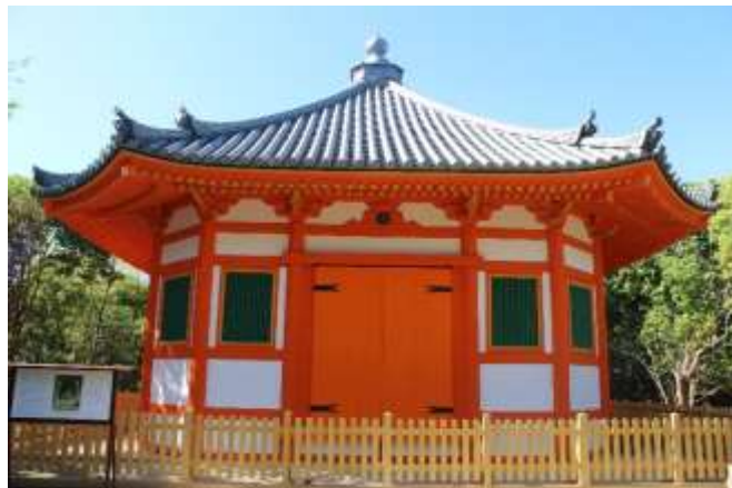
保存修理工事後の八角堂
