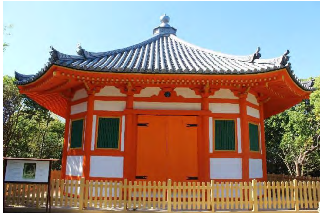
保存修理工事後の八角堂
