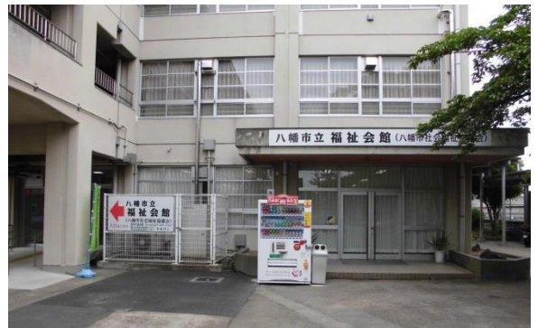
（平成 29 年 5 月設置）
