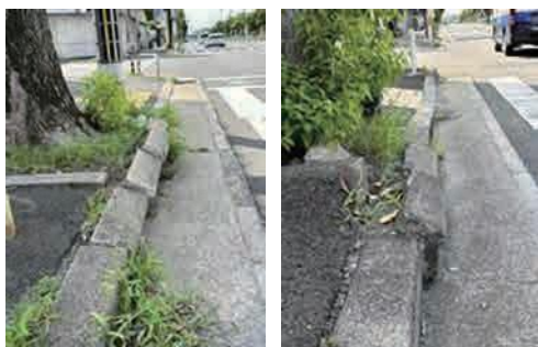
街路樹の根の影響により大きく傾いた縁石
