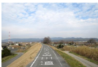
木津川の自転車道（現況）
