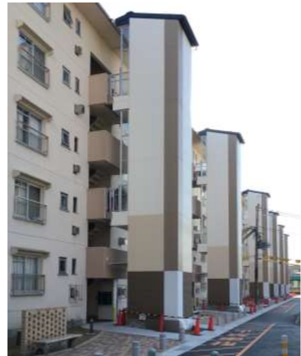
エレベーター設置工事の写真
