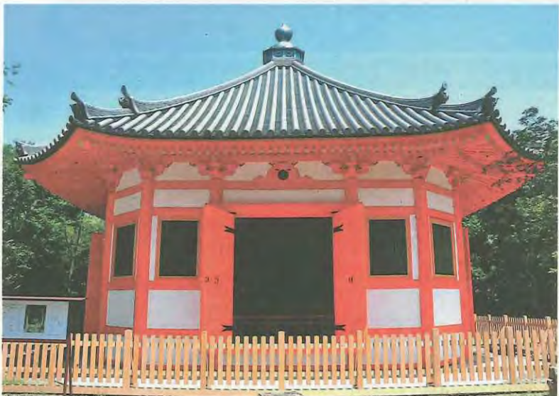
保存修理工事が完了した八角堂
