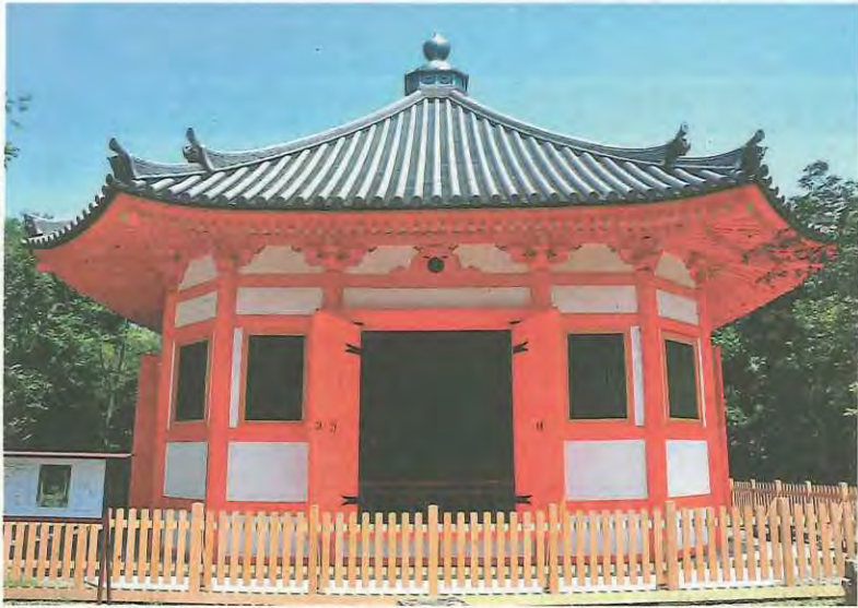
保存修理工事が完了した八角堂
