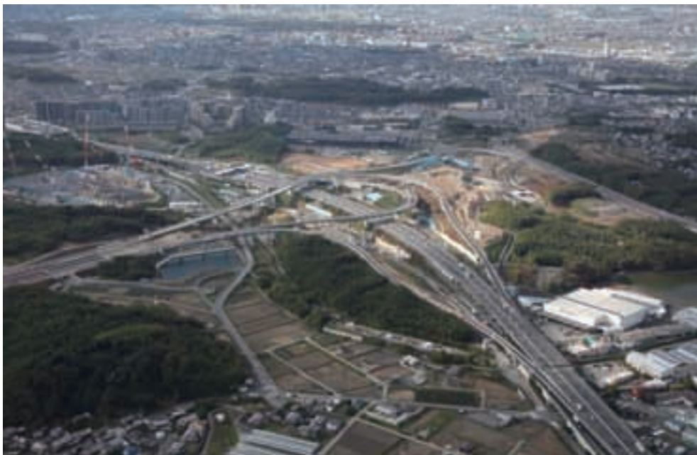
新名神高速道路城陽JCT・IC～八幡京田辺JCT・IC（平成29年4月開通）
