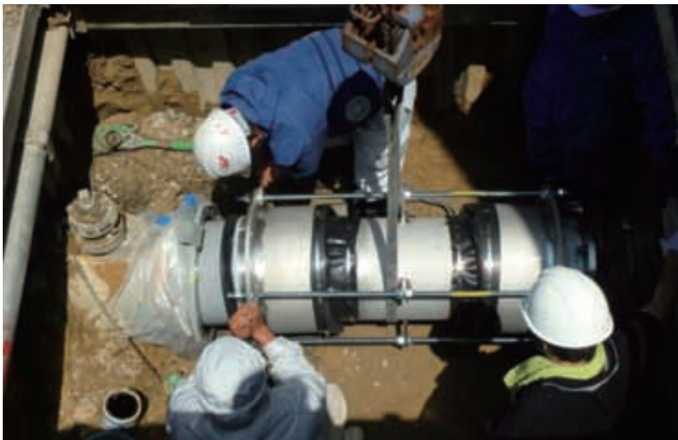
水道管の布設替・耐震化工事
