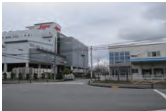
上津屋工業団地
