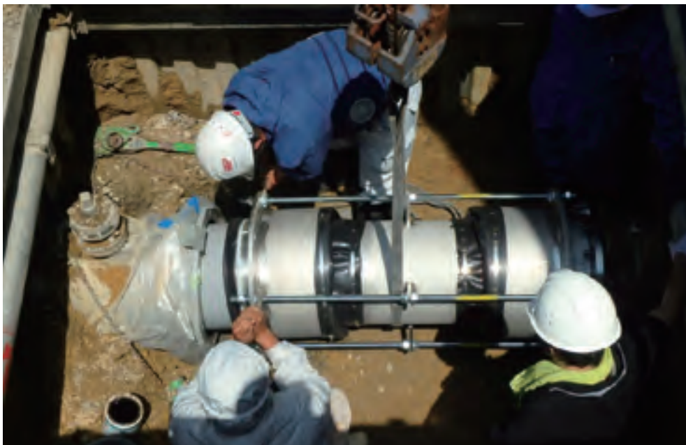
水道管の布設替・耐震化工事
