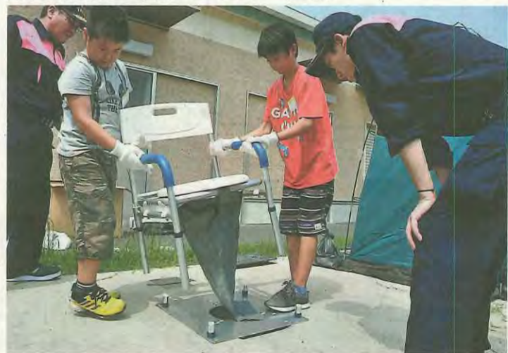
マンホールトイレを設置する子どもたち
