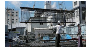
図 1-11. 鉄筋先組工法
