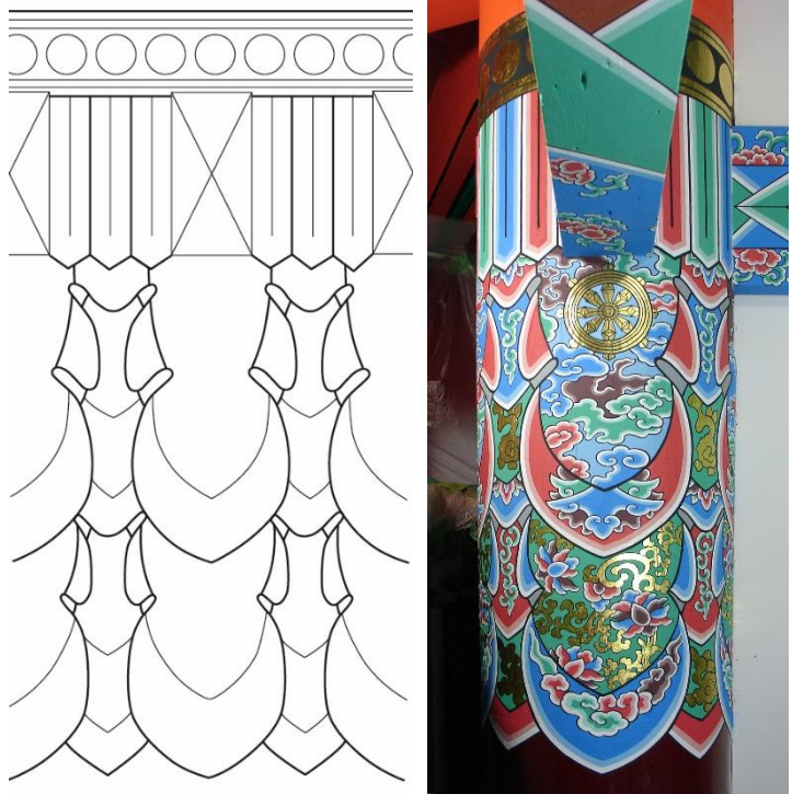
柱の彩色復原図と復原後の様子
