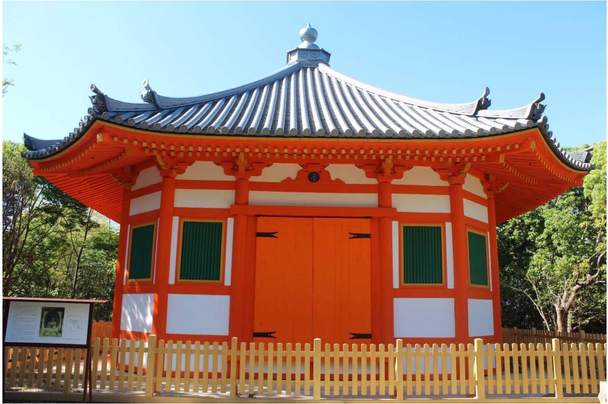
平成 31 年 3 月に保存修理工事を終えた八角堂
