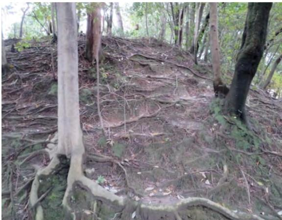
写真 5-1 表土流亡が生じている築山斜面
