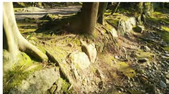
写真 5-2 樹根の延伸による石垣・石積の破損
