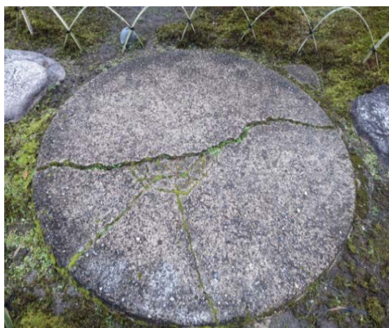
写真 5-3 人造伽藍石の破損状況（書院前庭）
