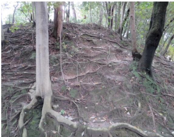
写真 5-1 表土流亡が生じている築山斜面
