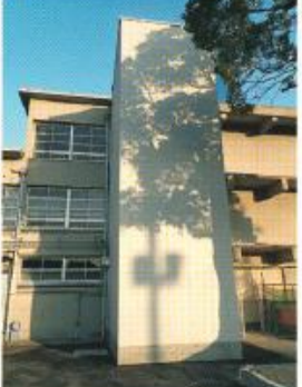
中央小の校舎に設置したエレベーターと外観
