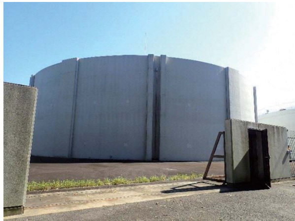
西山第1配水場
