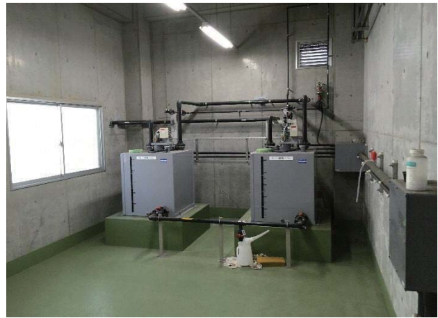
次亜塩素酸ナトリウム注入設備
