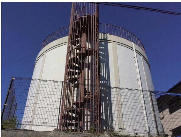
栗ヶ谷配水池
