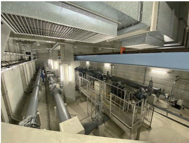
送水ポンプ室
