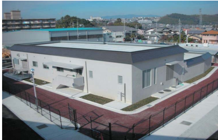
月夜田受水場の全景
