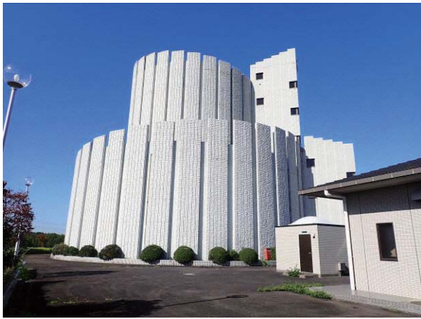
美濃山高区配水場
