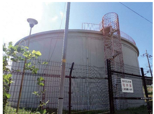
隅田口配水池
