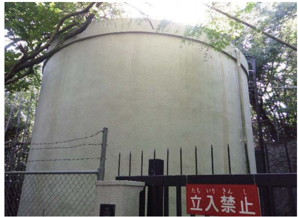
西山第2配水池
