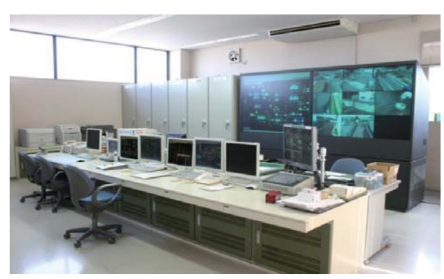
中央監視室の様子
