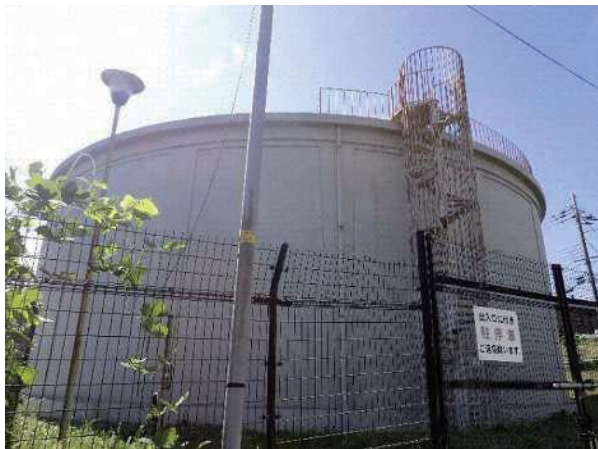
隅田口配水池
