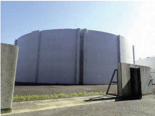
西山第1配水場
