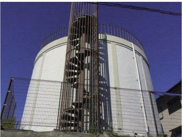
栗ヶ谷配水池
