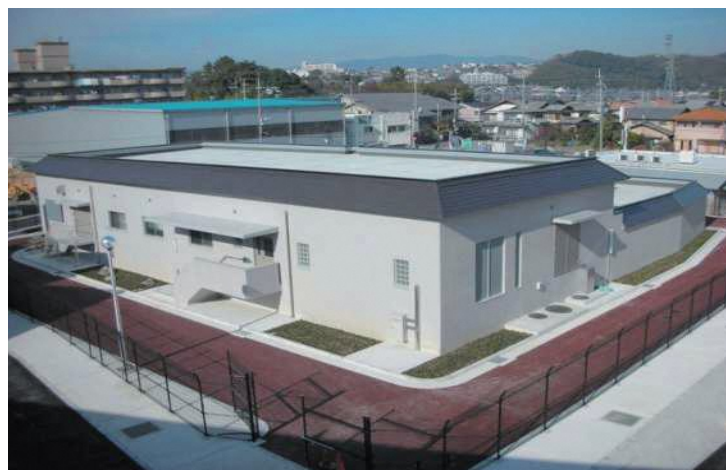
月夜田受水場の全景
