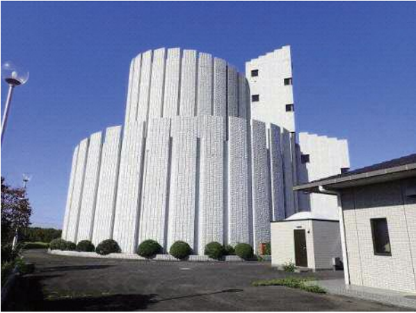
美濃山高区配水場
