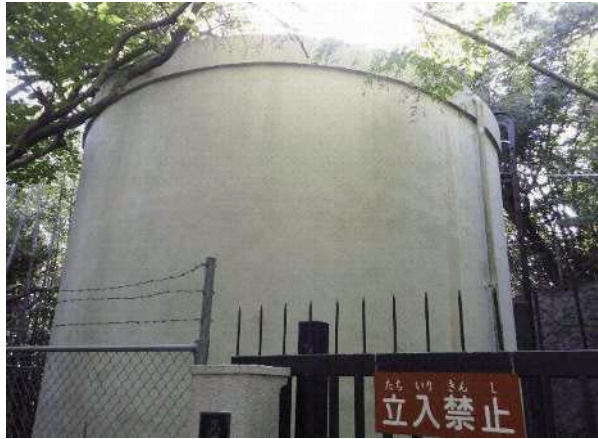
西山第2配水池
