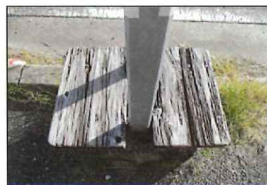
▲ コミュニティバスのバス停（川口萩原バス停）の老朽化状況
