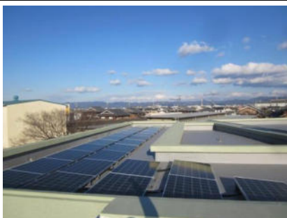
川口コミュニティセンターに設置された太陽光パネル
