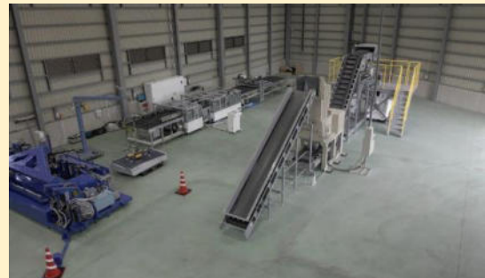
株式会社浜田 京都 PV リサイクルセンター （京都府八幡市下奈良小宮 4-2）
