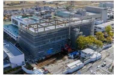
▲ 工事状況（令和 4 年 1 月）
