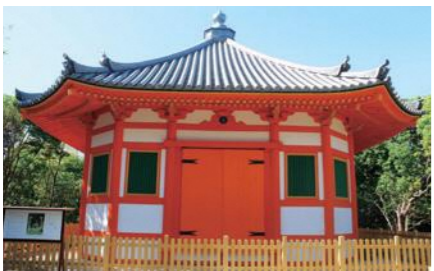
12 八角堂 保存修理工事完了
