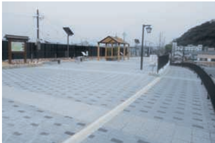
市道科手土井線歩道整備
