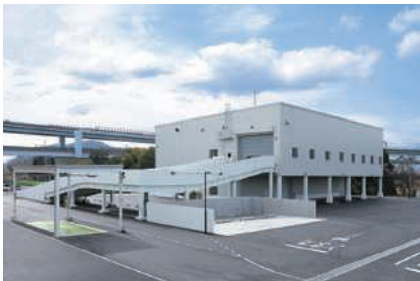
沢中継場（ごみ中継施設）
