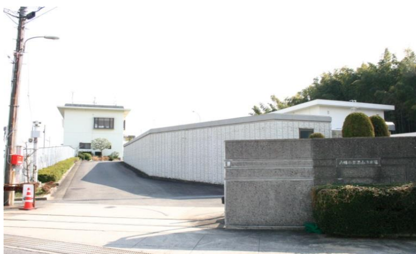
美濃山浄水場
