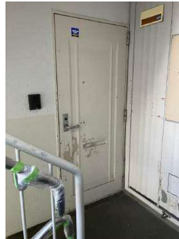
▲ 塗装前の玄関扉
