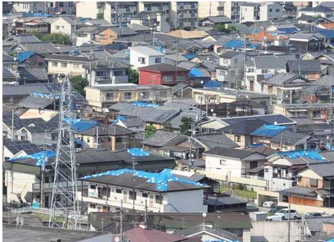
大阪府北部地震により、ブルーシートで補修している市内の家屋
