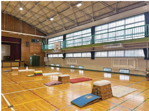
八幡小学校体育館の空調室内機と 放射式パネル
