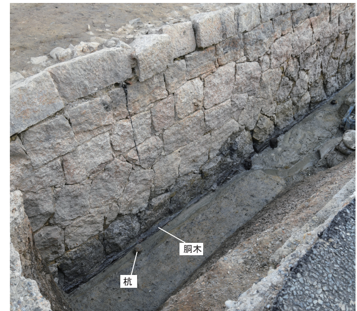
写真4 a区石垣・胴木（北西から）
