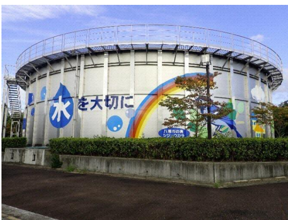
美濃山低区配水池
