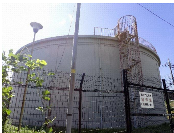
隅田口配水池
