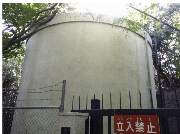
西山第2配水池
