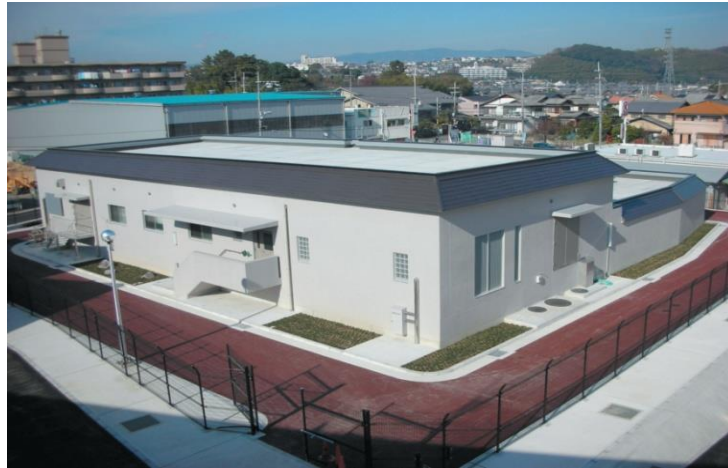
月夜田受水場の全景
