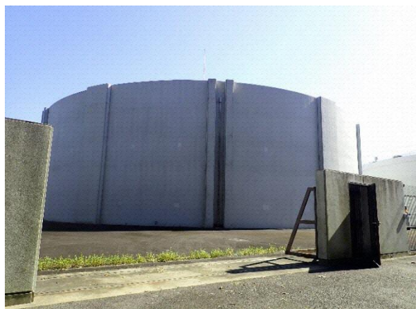
西山第1配水場
