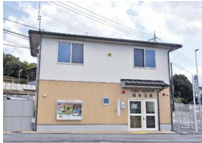
橋本駅前ロータリー に移転した橋本交番
