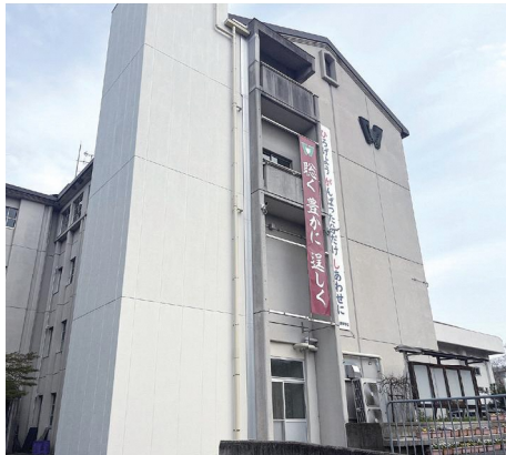
男山東中学校のエレベーター
