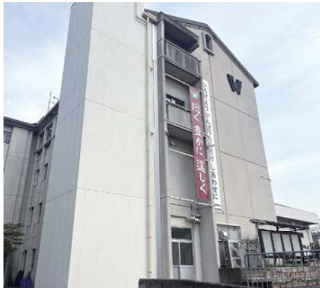
男山東中学校のエレベーター
