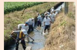
水路の泥上げ
