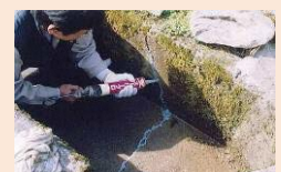
水路のひび割れ補修
