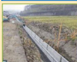
用水路の改修
