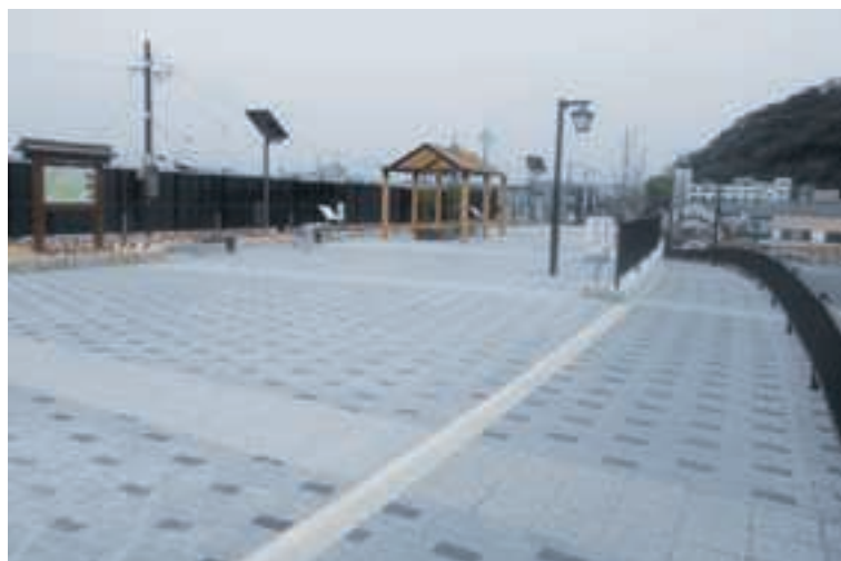
市道科手土井線歩道整備
