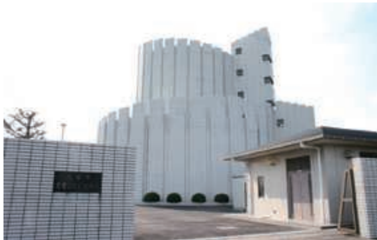
美濃山高区配水場
