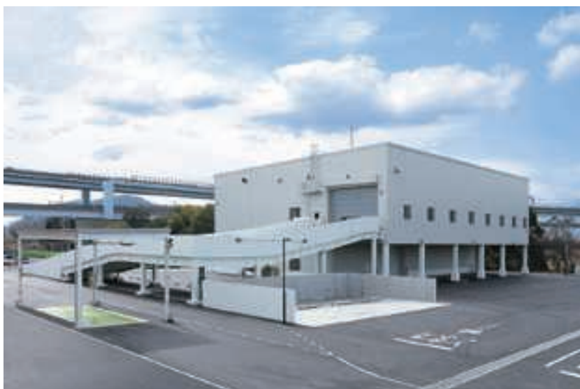
沢中継場（ごみ中継施設）
