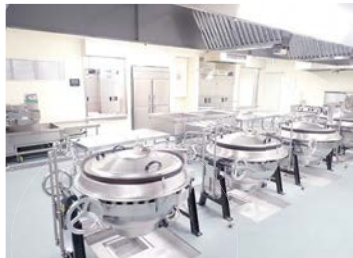
■さくら小学校給食室
