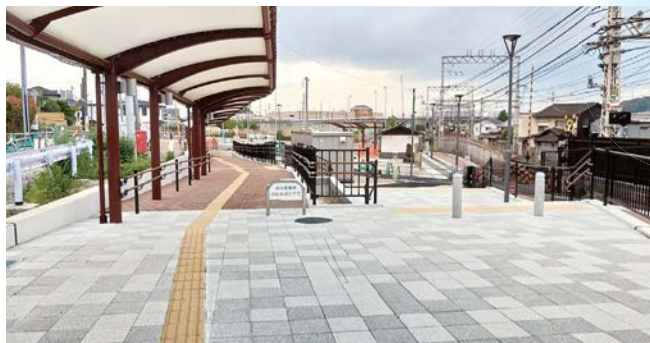
■橋本駅前広場シェルター
