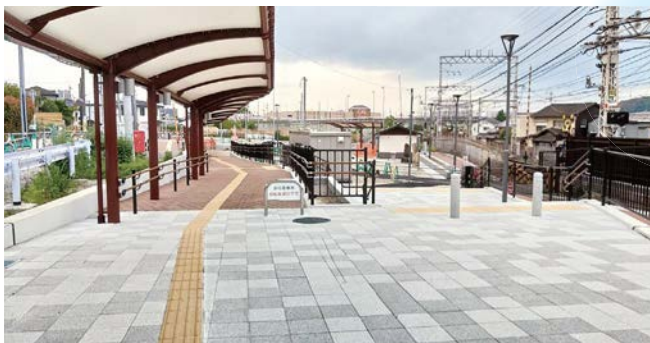
■橋本駅前広場シェルター
